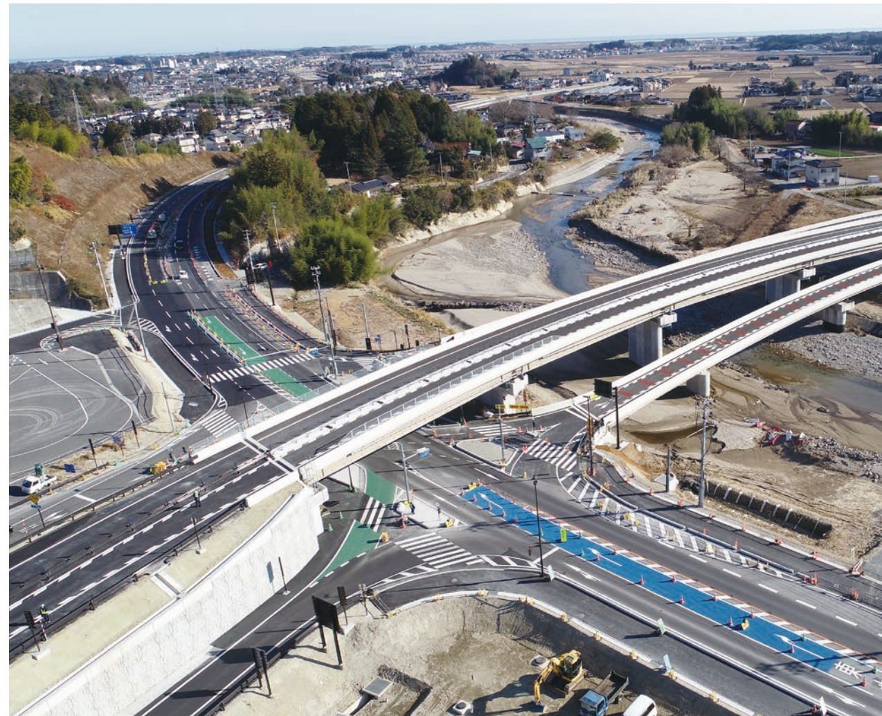
インターチェンジの整備
