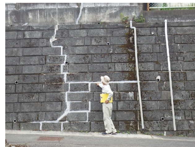
宅地擁壁の点検
