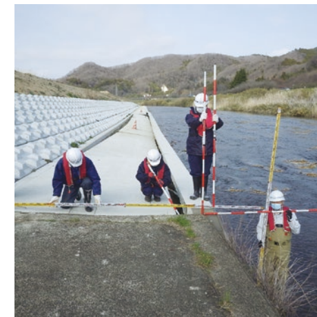
地震により被災した河川施設:宮城県
