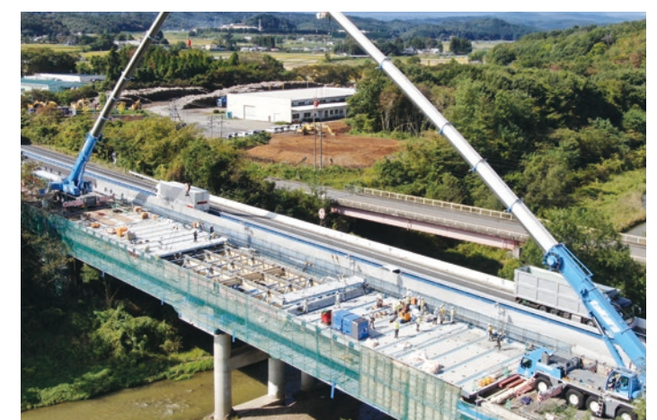
東北自動車道橋梁リニューアル工事：福島県郡山市 (東日本高速道路株式会社(NEXCO東日本)提供)
