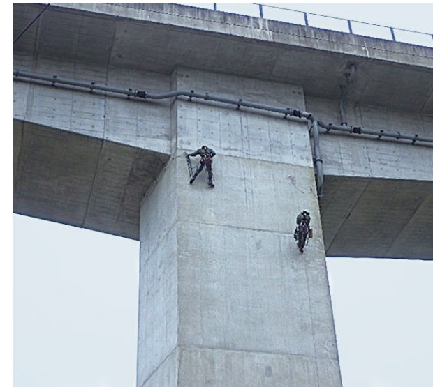
高所におけるロープ点検
