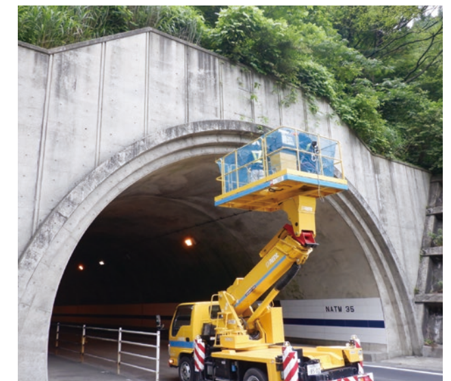
トンネル点検
