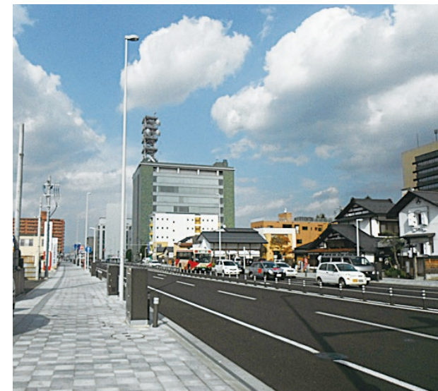
主要幹線道路の電線共同溝整備
