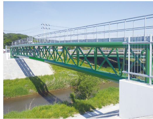
水管橋新設設計:宮城県
