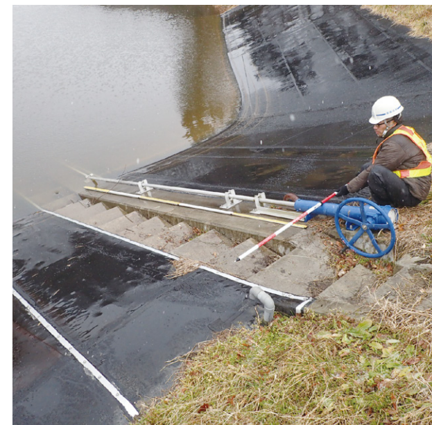
ため池施設点検:宮城県
