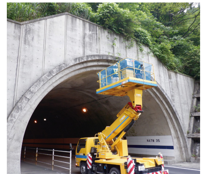
トンネル点検
