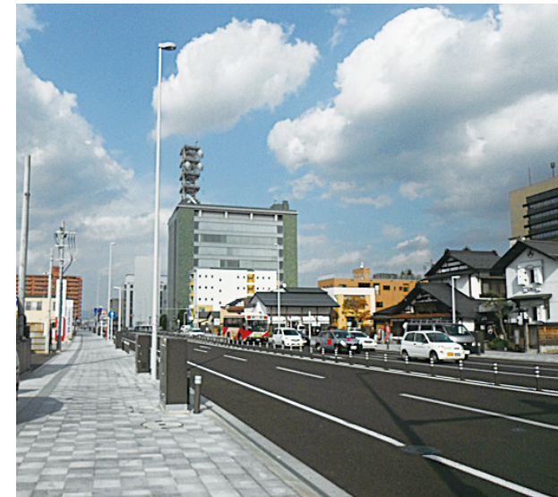
主要幹線道路の電線共同溝整備
