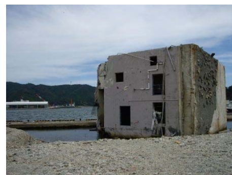
写真2 現場視察 (女川町)
