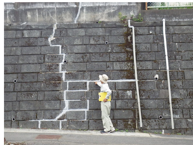
宅地擁壁の点検
