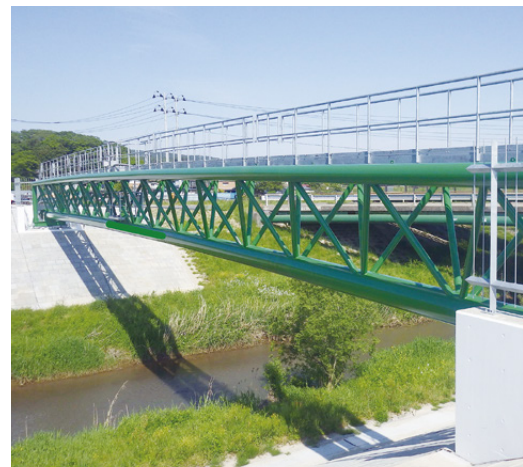
水管橋新設設計：宮城県
