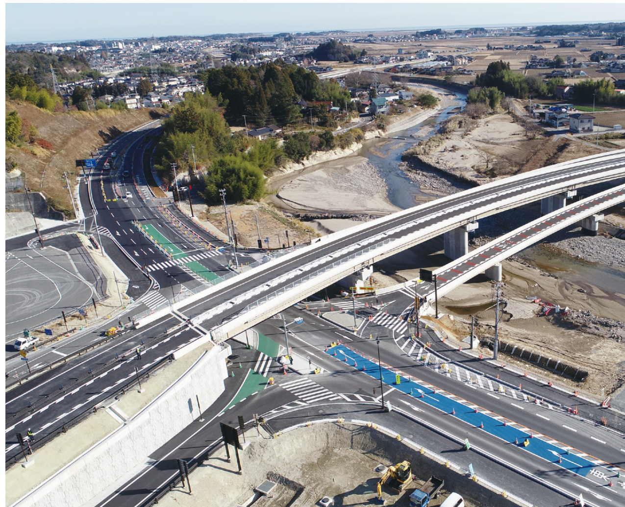
インターチェンジの整備
