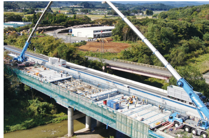
東北自動車道橋梁リニューアル工事：福島県郡山市 (東日本高速道路株式会社(NEXCO東日本)提供)
