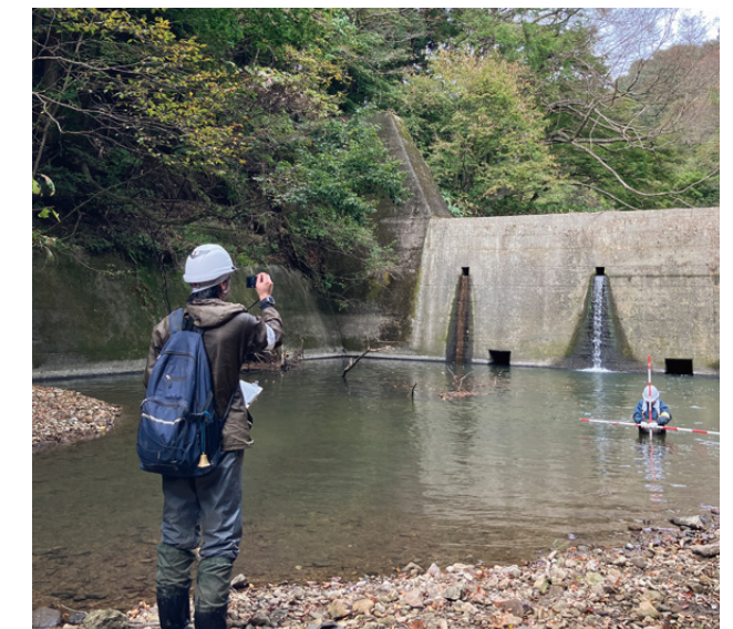
砂防施設点検
