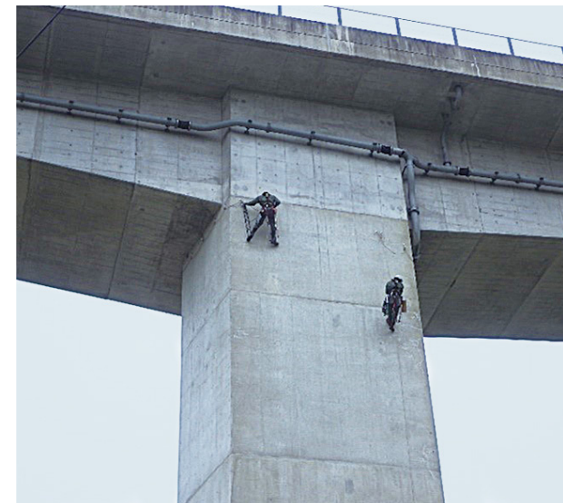
高所におけるロープ点検
