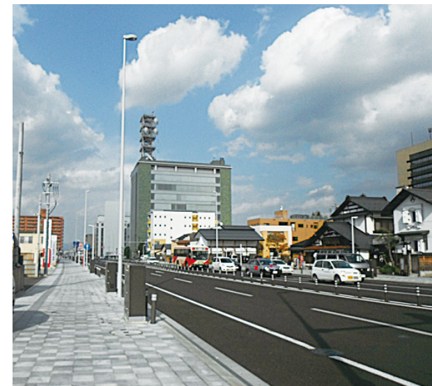
主要幹線道路の電線共同溝整備
