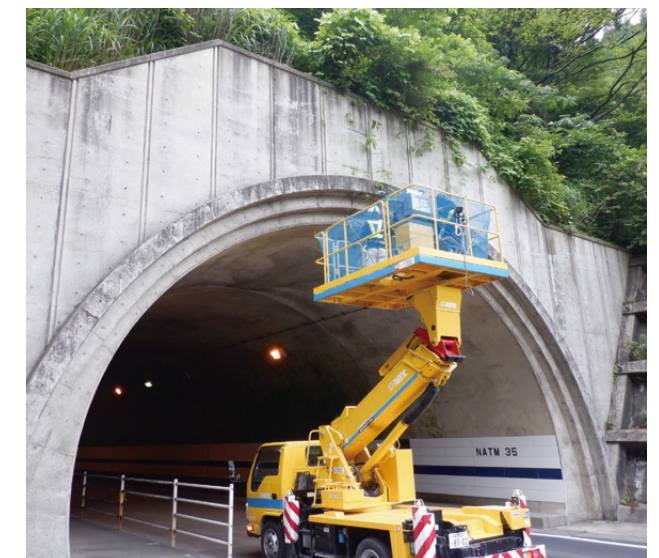
トンネル点検
